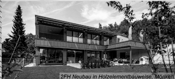
2FH Neubau in Holzelementbauweise, Möriken
