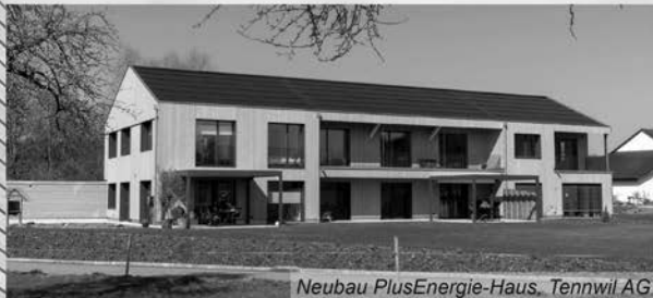
Neubau PlusEnergie-Haus, Tennwil AG
